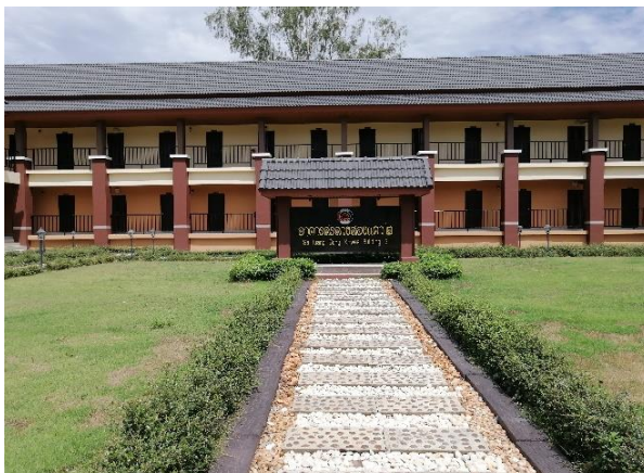
อาคารที่พักสรลงสองแคว ๒ ที่พัก ๓๒ ห้อง
