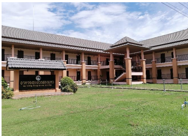
อาคารที่พักสรลงสองแคว ที่พัก ๓๒ ห้อง
